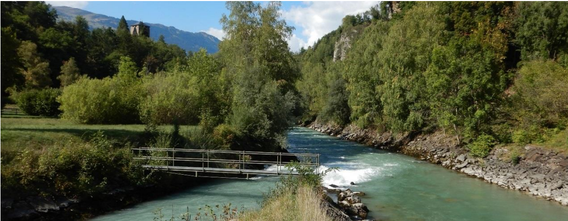
Abbildung 6 Albula, Abschnitt 1.2 (rechts)unterhalb der Zentrale Sils mit beidseitigen Wuhrmauern. Links ist der Abschnitt 1 des Albula Kraftwerk 1 sichtbar (künstliches Gerinne).
