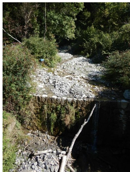
Abbildung 11 Clusa, Abschnitt 1. Bachbett mit künstlich angelegter Schwelle. Die gemauerte Steilböschung an der Seite ist aufgrund des starken Bewuchs nicht auf dem Bild erkennbar.
